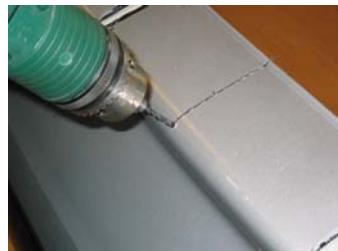
По дължина на пукнатината трябва да се оформи V-образен канал от 90° с фрезер, който е предназначен за поемане на добавъчния материал.
